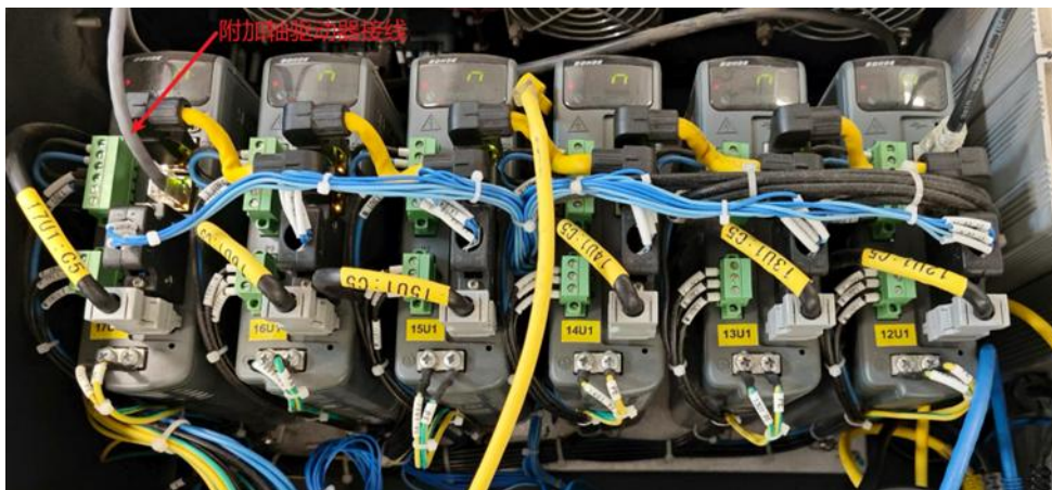
图 6 驱动器接线
